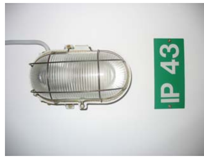
Ryc. 33. Lampa oświetleniowa z kloszem i osłoną. [Fot. E. Marciniak]
