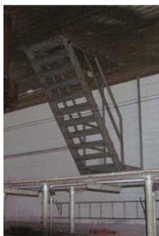
Ryc.41. Właściwie wykonane wejście na poddasze
