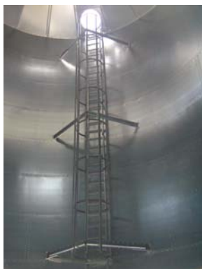
Ryc.22. Wnętrze silosu zbożowego – ochrona wjazdu,
