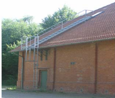
Ryc. 43. Odpowiednio wykonane zabezpieczenie pracy na wysokości – drabina, poręcze,
