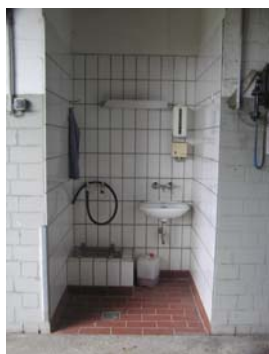
Ryc.113. Miejsce do mycia rąk w budynku inwentarskim
